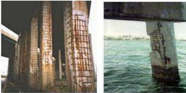
**Gambar 7.** Ilustrasi kerusakan baja tulangan di dalam beton
